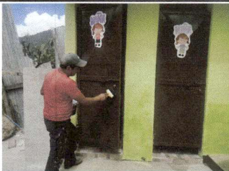
Foto 1: Pintando las puertas del baño.
