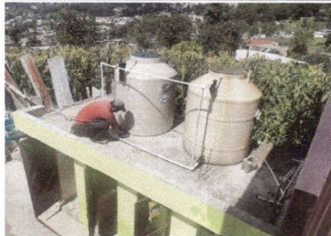
Foto 8: Reparación y colocación de nuevo depósito de agua.
