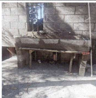
Foto 3: Sustitución de lavamanos.
