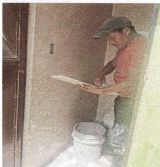
Foto 7: Colocación de azulejo en piso y paredes de baños.
