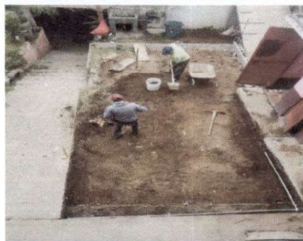
Foto 2: Cambio de piso de cemento.
