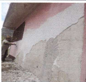
Foto 5: Reparación y alizado de pared de fachada.
