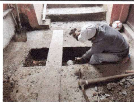
Foto 6: Sustitución de piso.
