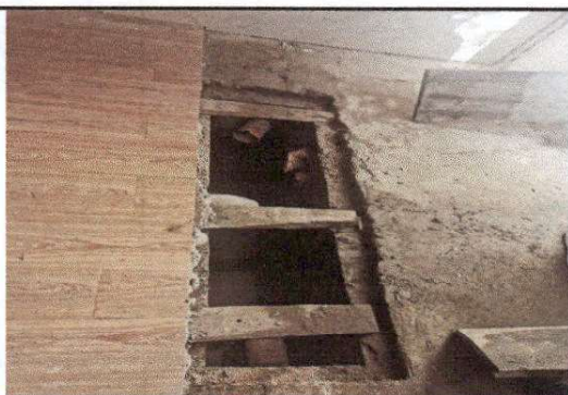
Foto 10: Reparación de rejilla.
